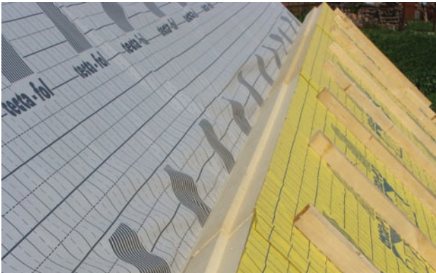
páraazáró fóliára fektetett 24 centiméter vastag poliuretán táblák
