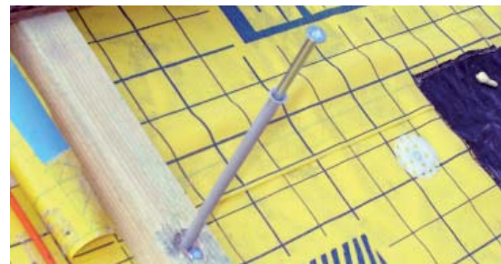
A rögzítés az ellenléceken és a hőszigetelésen keresztülmenő speciális dübelekkel történik
