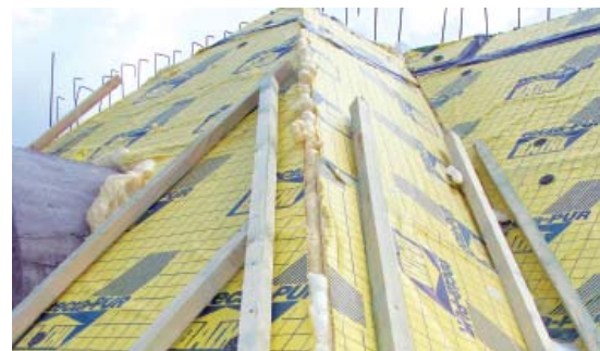
Élnél, vápánál, gerincnél monolit PUR-habbal kell tömíteni a táblák vágott élei közötti rést
