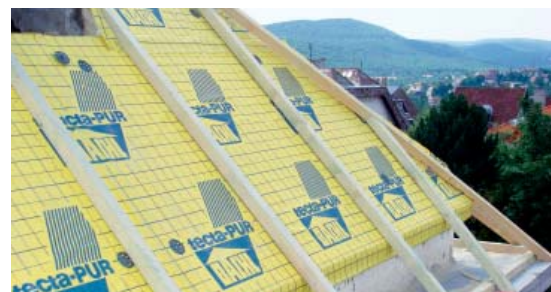
A vasbeton koporsófödémén megszakítások nélküli kialakított hőszigetelés poliuretán keményhab táblákkal
